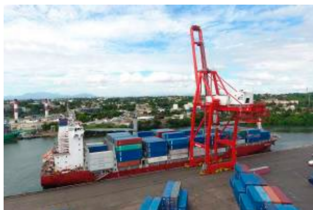
Muelle con grúa Gantri para portacontenedores.
