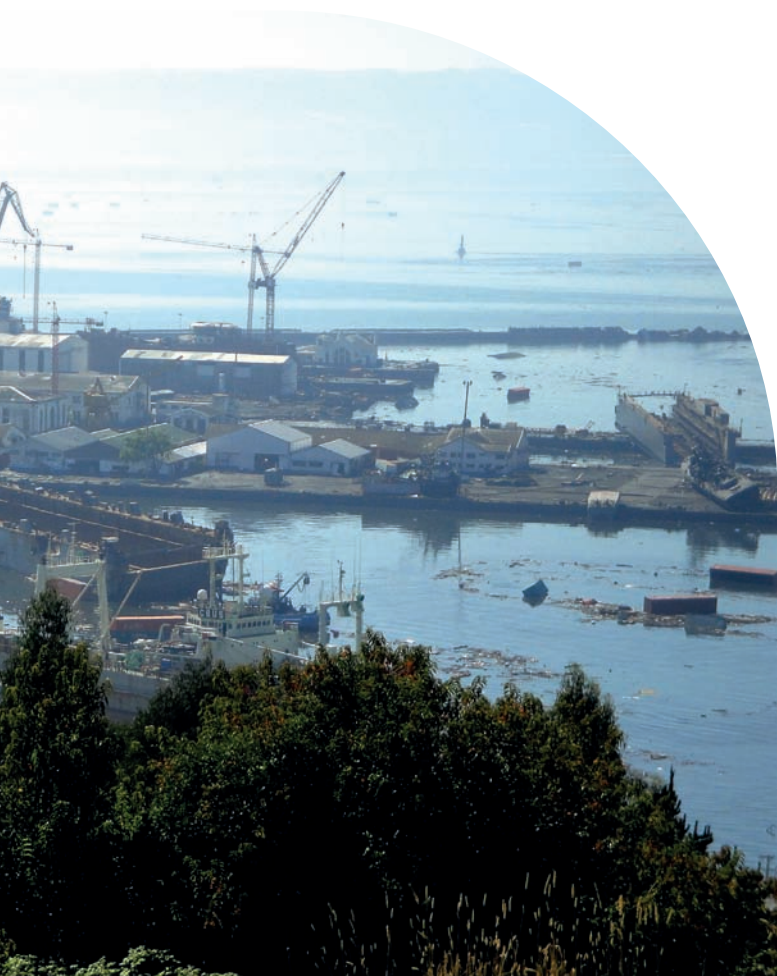
Una de las zonas más devastadas por el terremoto y tsunami del 27 F, fue el puerto de Talcahuano.
