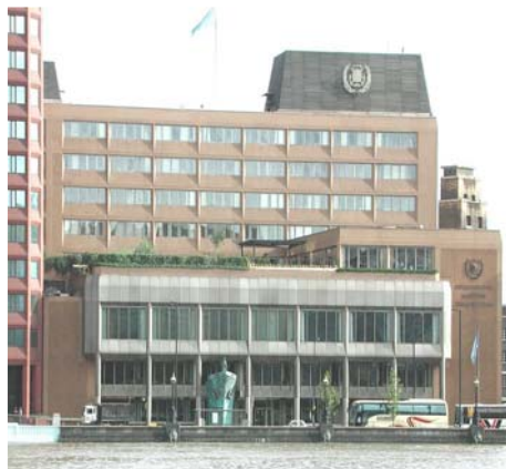
Edificio de la OMI
