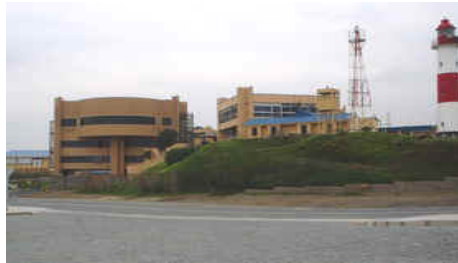
Edificio y Simuladores de CIMAR
