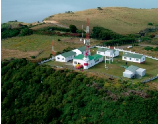
Faro y casas para habitabilidad del personal
