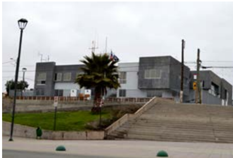
Actuales dependencias de la GM de Caldera.
